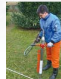
Création de fondations.
