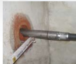
Forages directs depuis les bâtiments.
