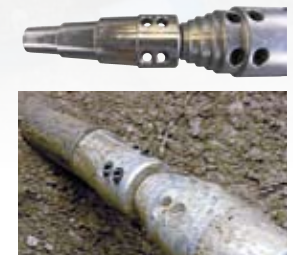
Extraction d'anciennes conduites d'acier.
